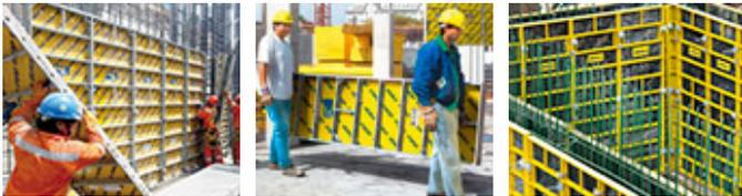
Encofrados - Encofrados de Tabiques o Muros
